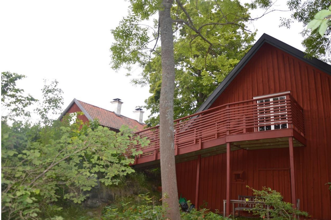
Figur 28. Äldre träbyggnader utgör potentiella kolonimiljöer för bland annat nordfladdermus och dvärgpipistrell. Om renoveringar utförs på ett sådant sätt att de hål som fladdermössen använt för att ta sig in i väggen eller på vinden försvinner kan de påverkas negativt.
